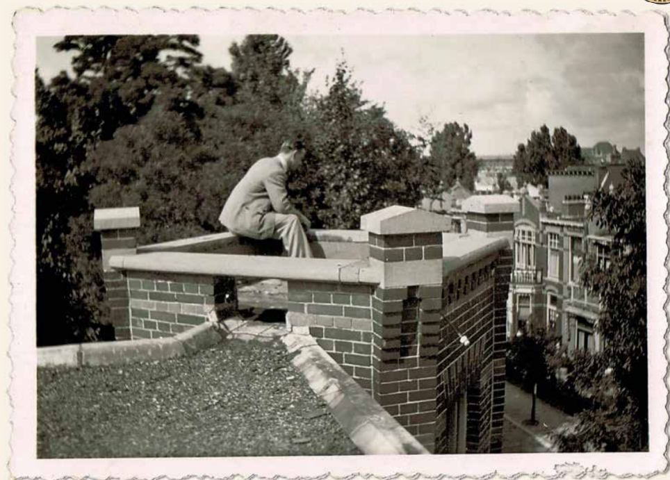
Piet en Bosch op het dak in de Oranjetaan
