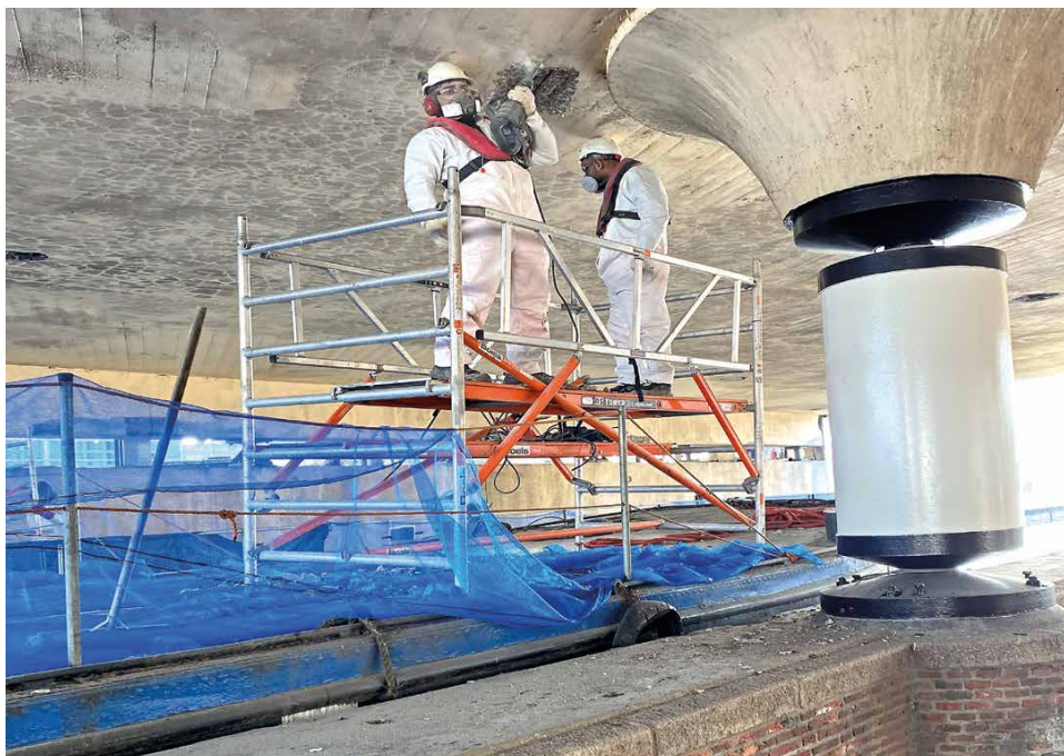
Onderhoud aan de Hoornbrug
